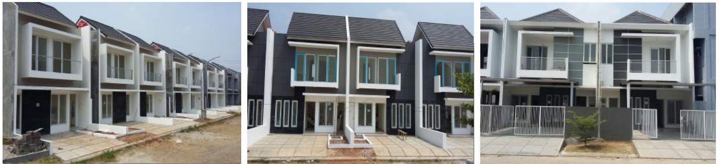
PEMBANGUNAN RUMAH DI LOKASI BOTANIA RESIDENCE, PESONA METROPOLITAN BEKASI
