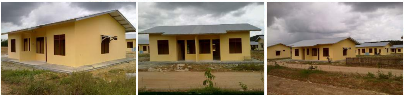
PEMBANGUNAN RUMAH ASTRA AGRO LESTARI
