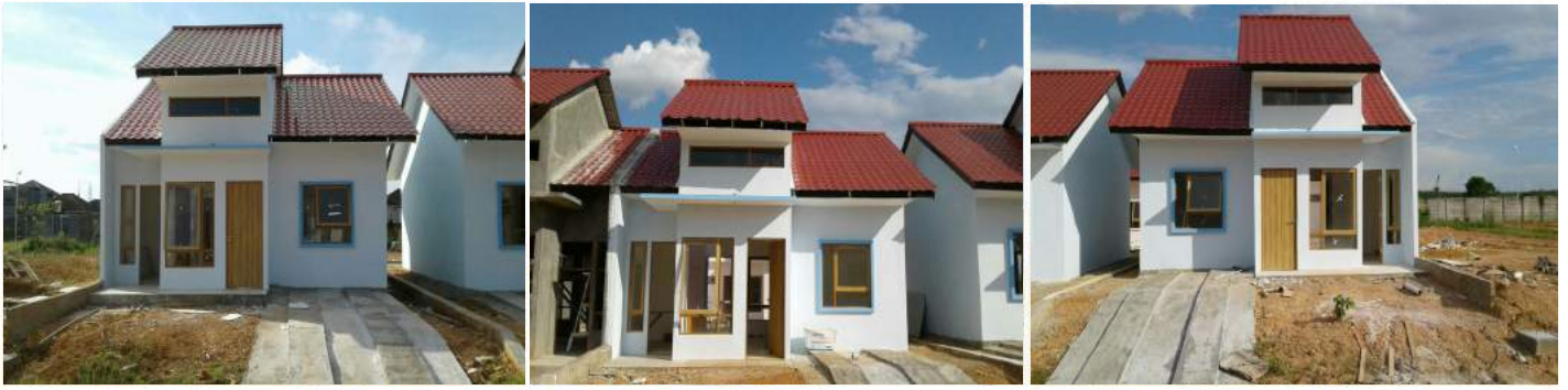
PEMBANGUNAN RUMAH DILOKASI PROPER GREEN VILLAGE, TANJUNG KALIMANTAN SELATAN
